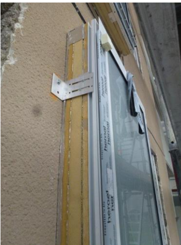
Die solarthermischen Lüftungselemente wurden als komplette Bauteile mit Wärmedämmung und Rahmen geliefert, sodass sie sich flächenebündig in die Fassade integrieren ließen. (Foto: Knauf)
