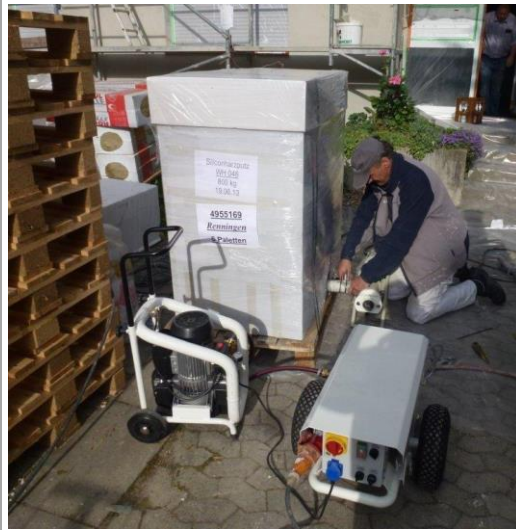
Logistische Lösungen wie der Sprinterservice oder die Putzverarbeitung aus dem Großgebäude – hier ein Cleverpack mit Förderpumpe für den Oberputz – unterstützen die schnelle und unkomplizierte Ausführung in Renningen. (Foto: Knauf)
